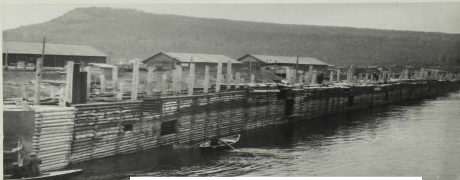
Строительство Осетровского речного порта
