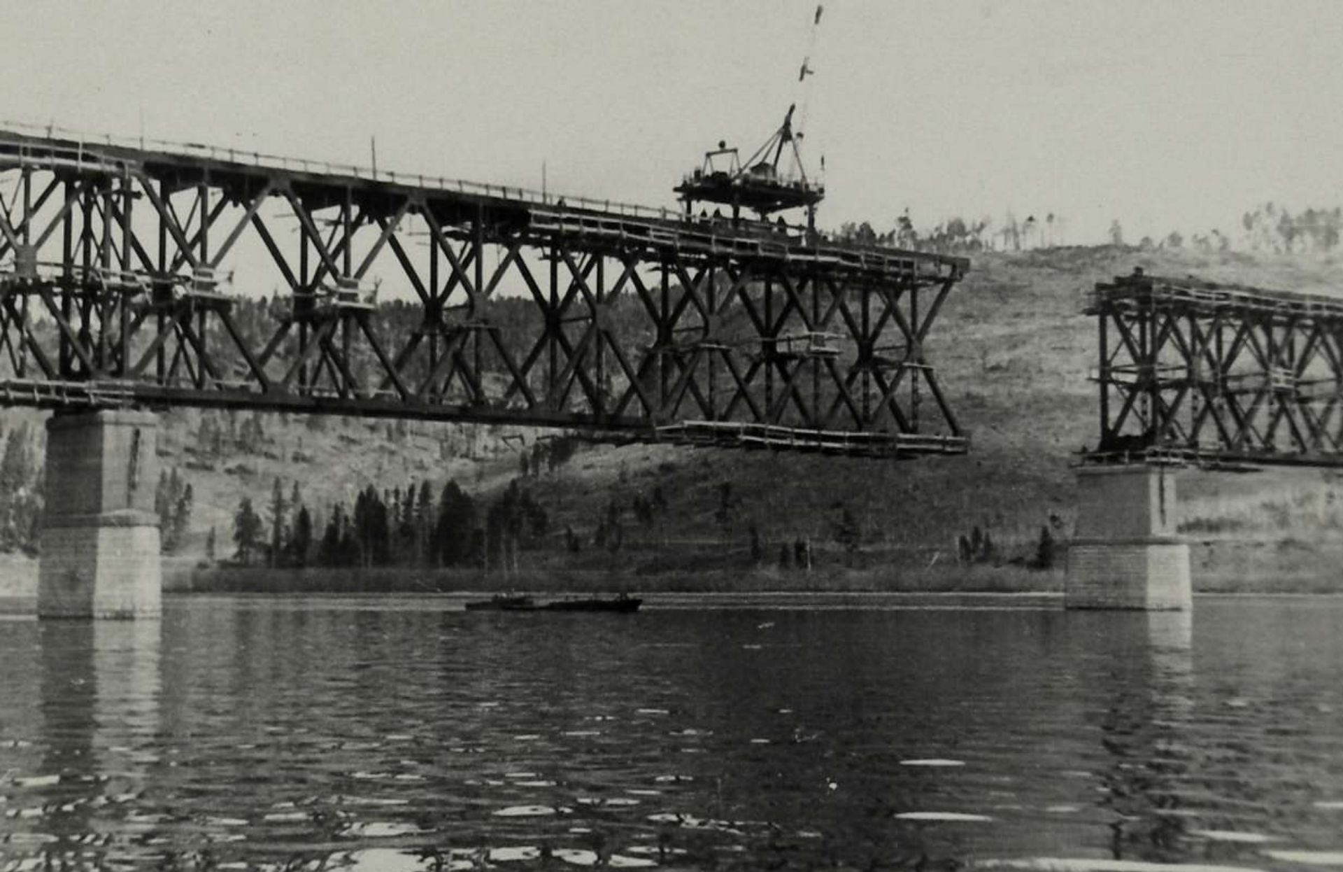
Строительство железнодорожного моста через р.Ангара. Монтаж металлических ферм навесным способом. Монтаж последней 9-ой панели последнего пролёта моста
