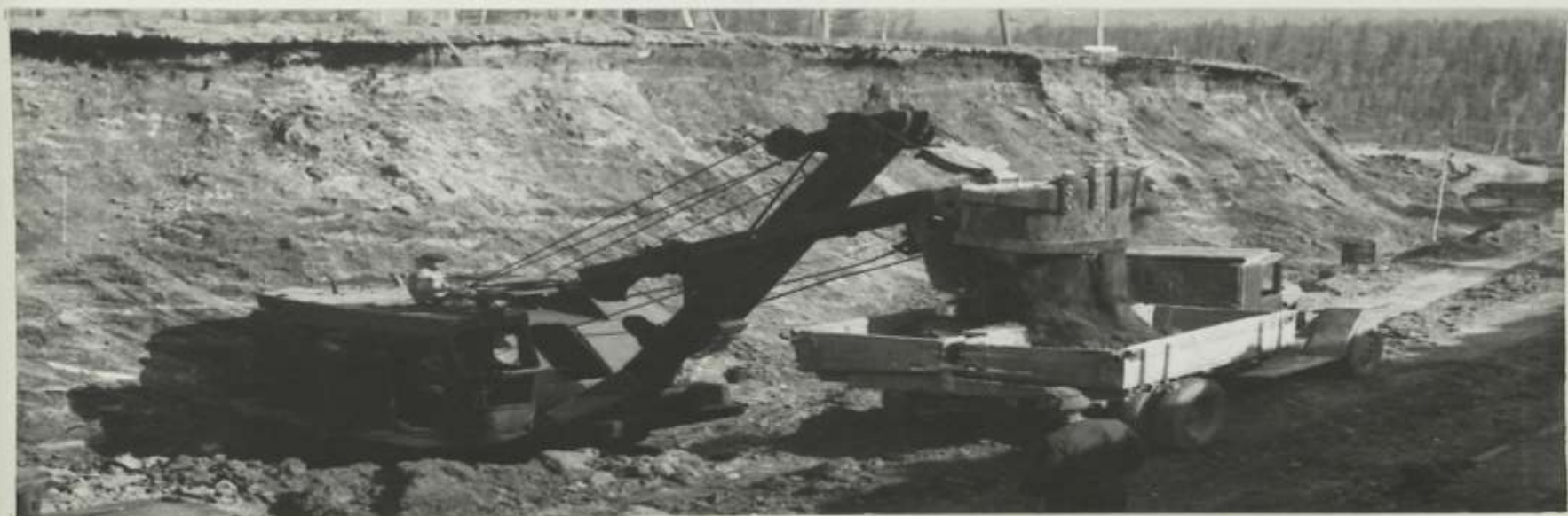
Погрузка грунта на автотранспорт экскаватором ОМ-201
