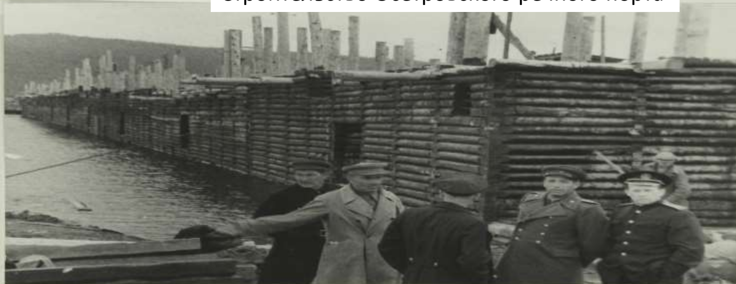
Строительство причальной стенки ДУРП Министерства СССР
