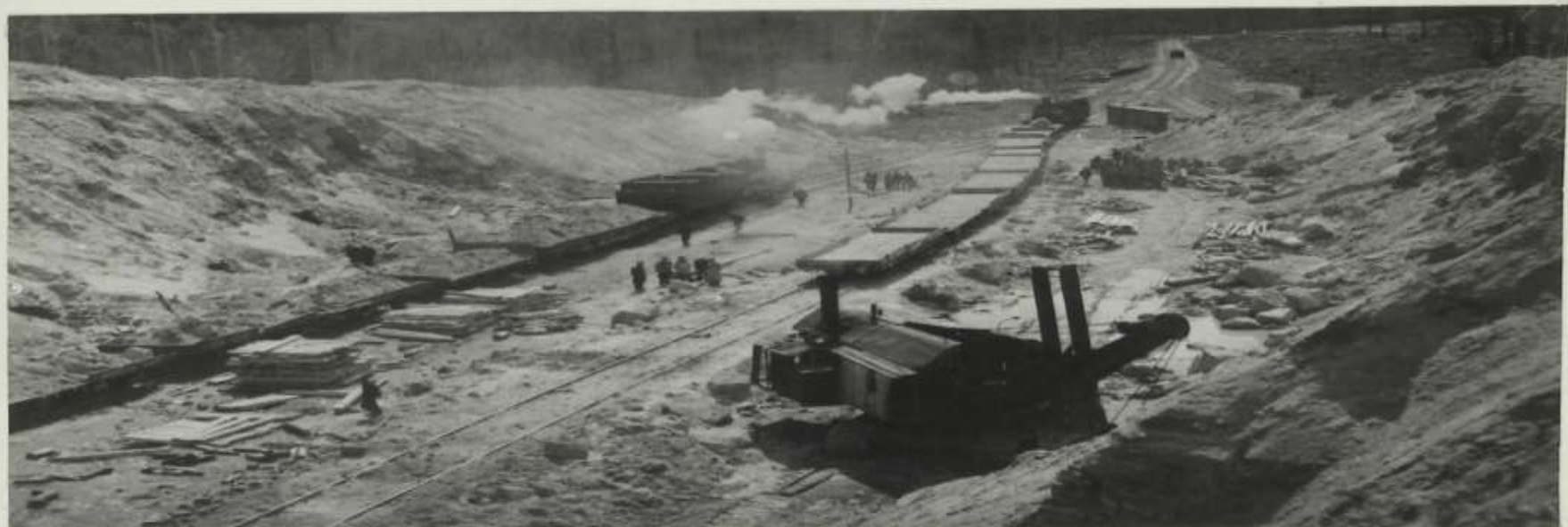
Погрузка грунта на ж/д платформы экскаватором ППГ-1,5
