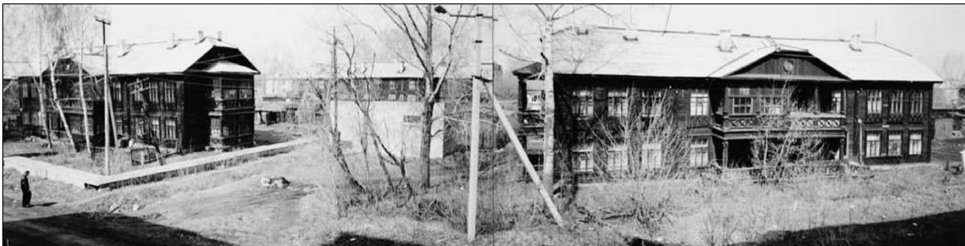
Улица Зои Космодемьянской. Панорама жилых домов, построенных в 1939-40 годах заключёнными для работников НКВД. Начало строительства Байкало-Амурской магистрали.
